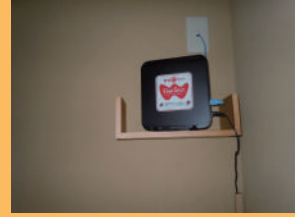
光回線：親機施工例
